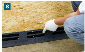
Монтаж стартовой полосы фасадной плитки начните от угла с отступом от края 5–10 мм. Удалите защитную пленку, отрежьте лепестки. Стартовую плитку установите в уровень земли на 11 гвоздей: 3 сверху, 8 снизу.
