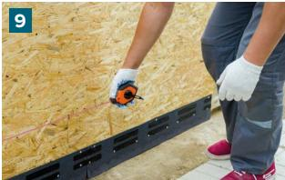
Отметьте точку на высоту одной плитки от уровня земли и отмерьте расстояние от верхней части подпорной стены до этой точки. Отмерьте это же расстояние на другом конце стены и соедините точки в направляющую линию с помощью шнурки-отбивки.
