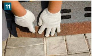
Рядовую плитку, выходящую на внешний угол, подрежьте так, чтобы расстояние от ее края до грани угла было 5–10 мм.
