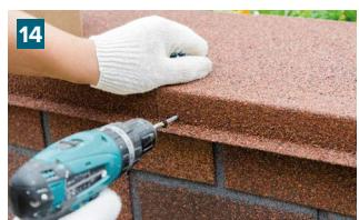
Зафиксируйте планку саморезами в цвет посыпки с шагом 300 мм.
