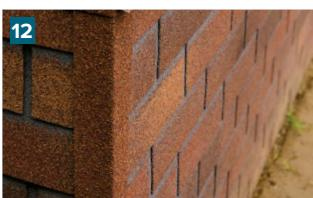
Угол установите снизу вверх с нахлестом ~5 см и закрепите с двух сторон специальными оцинкованными саморезами по металлу с шагом 300 мм.
