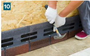
Каждую рядовую фасадную плитку прикрепите к основанию с помощью специальных оцинкованных гвоздей с широкими шляпками. Количество гвоздей - 8 шт на плитку, по 2 гвоздя на лепесток.
