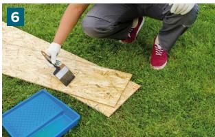
Перед монтажом направляющих и настила, обработайте их полимерной либо битумной гидроизоляцией на высоту не менее 300 мм от уровня земли.
