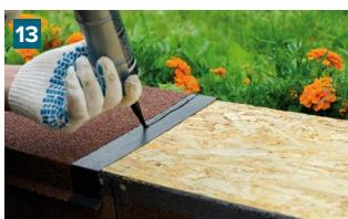
Верхнюю часть подпорной стенки закройте природным камнем либо специальной П-образной планкой. Монтаж планок проведите с нахлестом 3-5 см. Место стыка двух планок промажьте герметиком.
