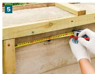
Шаг установки вертикальной обрешетки – 300 мм.
